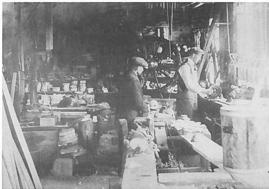
Interiørbilde fra Kovigen Dampblokkmageri ved Arendal. Vi ser blokkmakeren i arbeid ved dreierbenken t.h., hans medhjelper ved høvelbenken. Vi ser ei sirkelsag t.v. i bildet, ei skruestikke av tre skimtes i forkant av høvelbenken. På hyllene i bakgrunnen skimtes deler til blokkhus, foran vinduet t.h. henger ferdige blokker, og foran t.h. står en fiskemorter. Vi ser også et skipsratt. Aust-Agder Museet.
