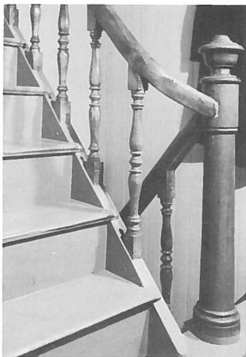
«Ballustre» og «meglere» til trapper var et blokkmakerprodukt i Lillesand. Også bygdehandverkere med dreierbenk kunne lage slike.
