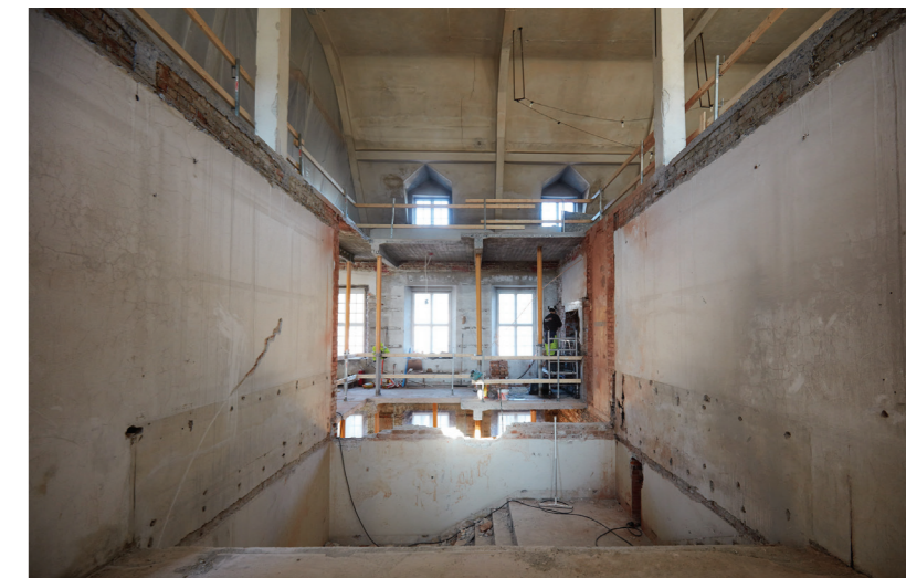
Det gamle trapperommet er revet for å gi plass til ny heis og trapp fra kjeller til loft, mars 2016.
