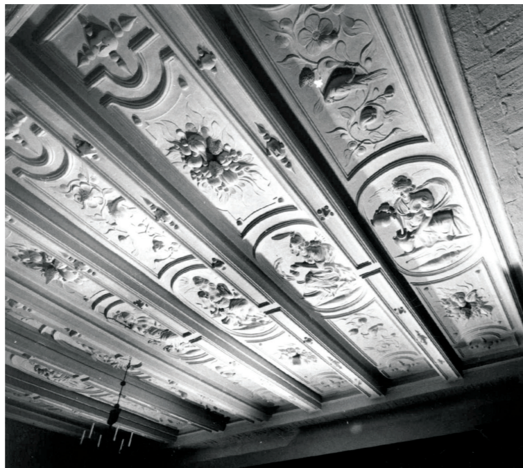
Stukktaket De syv dyder over renessanserommet i Bysamlingen. Bildet gir et inntrykk av hvordan taket er inndelt i felter mellom kalkede takbjelker. Foto: Norsk Folkemuseum.
